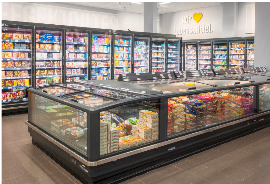
Kälteanlagen können beim Umbau gefördert werden, ebenso Kühlmöbel mit Türen.
